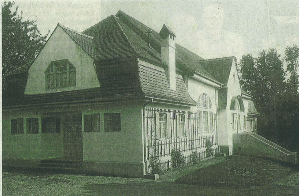
Raum für Begegnungen: 1910 begannen die Bauarbeiten für den Kapplerbräusaal. SCH
